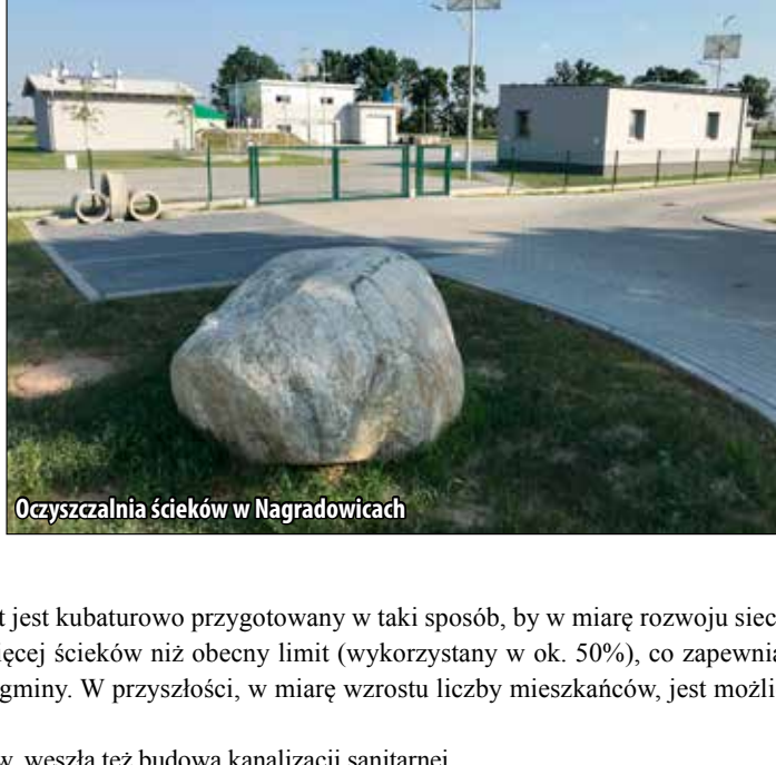
Oczyszczalnia ścieków w Nagrodawicach
