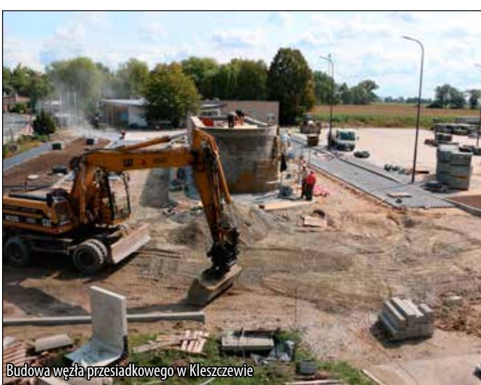
Budowa węzła przesiadkowego w Kleszczewie
