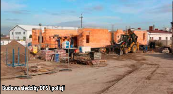
Budowa siedziby OPS i policji
