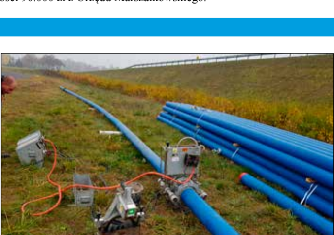
Budowa nowego wodociągu
