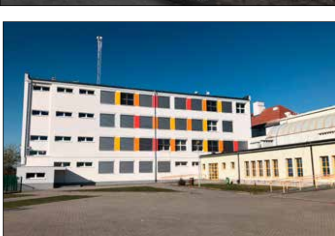
Zespół Szkół w Kleszczewie po termomodernizacji
