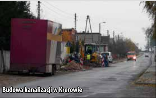
Budowa kanalizacji w Klerowie
