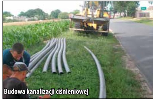
Budowa kanalizacji ciśnieniowej
