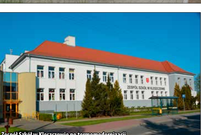
Zespół Szkół w Kleszczewie po termomodernizacji
