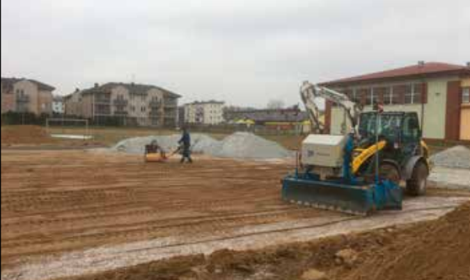
Budowa boiska w Tulcach
