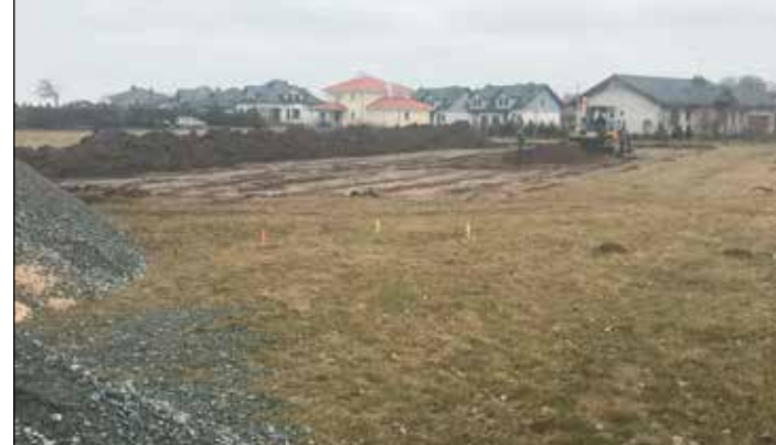
Budowa boiska w Gowarzewie
