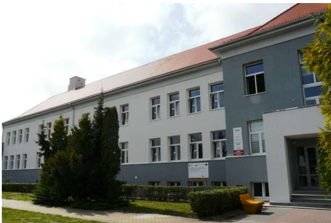
Zespół Szkół w Kleszczewie – „stary” budynek
