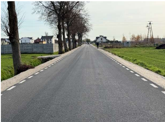
Fot. Droga powiatowa 2441 P odcinek Kleszczewo-Poklatki – inwest. ZDP
