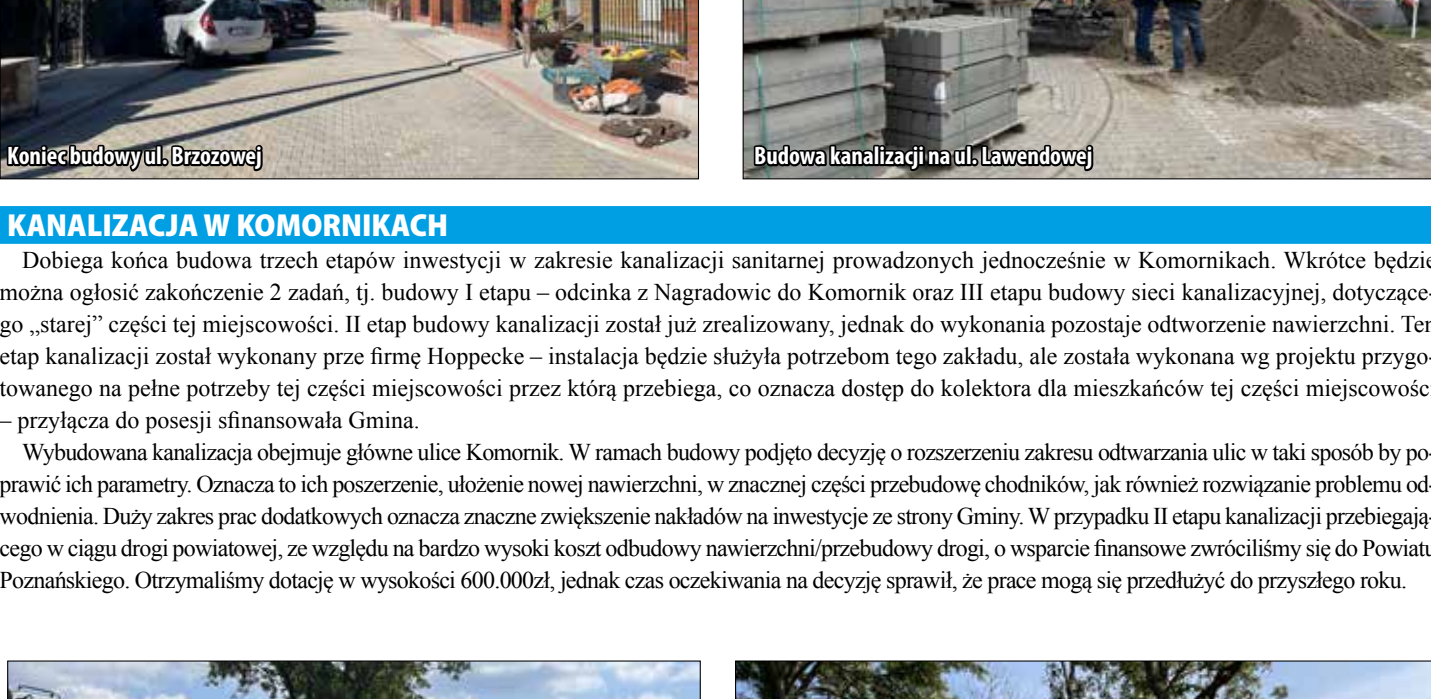
Koniec budowy ul. Brzowej
