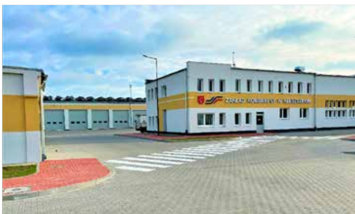
Zaplecze techniczne komunikacji baza Zakładu Komunalnego – listopad 2021 r.
