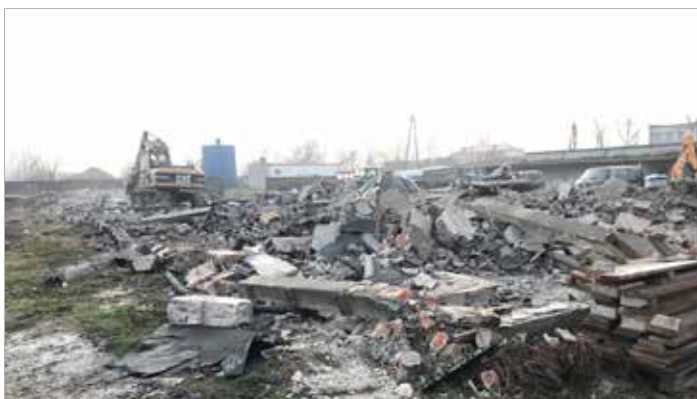
Rozpoczęcie przebudowy bazy Zakładu Komunalnego – grudzień 2019 r.
