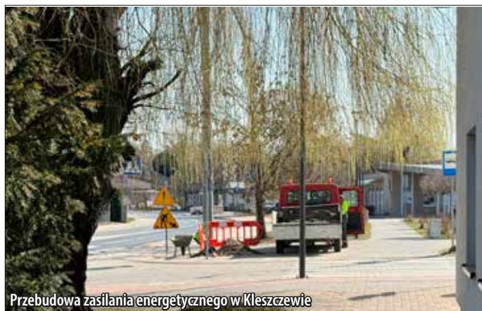
Budowa ulicy Topolowej w Kleszczewie
